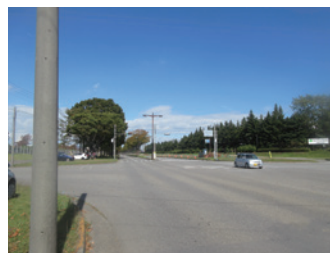
LRT 軌道敷設のために街路樹が伐採された清原工業団地
